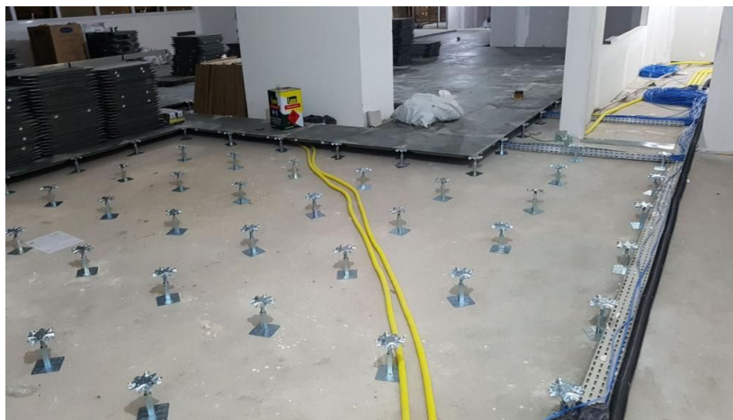
Figura 14 - Instalação de piso elevado sobre a laje.
